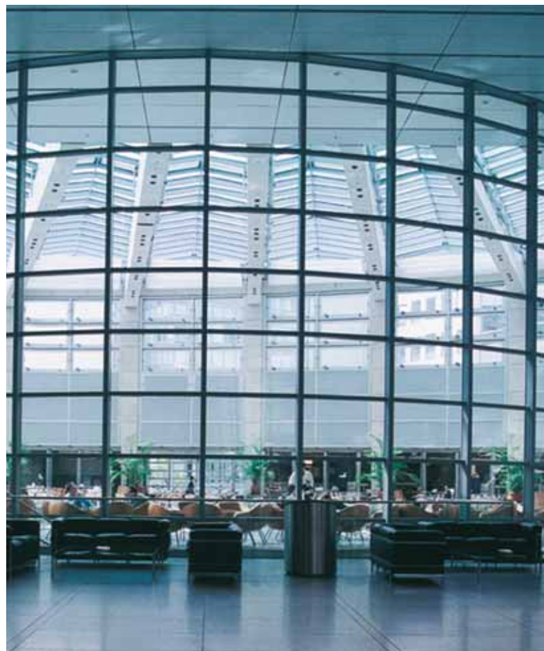
Alimentación de energía para el edificio de oficinas más alto de Europa con GEAFOLE
